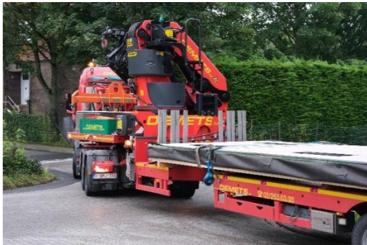
Afbeelding 14. Aankomst van de module ter plaatse
