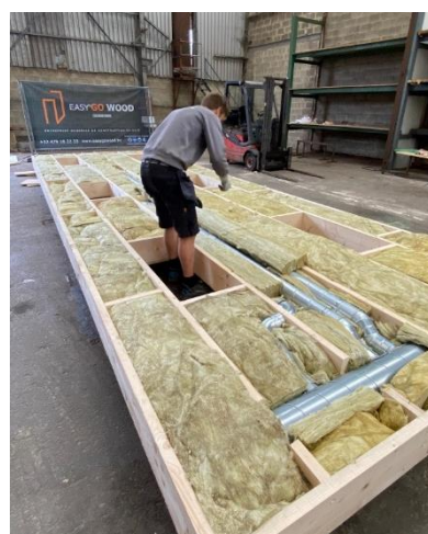
Afbeelding 13. Definitieve plaatsing van de isolerende laag
