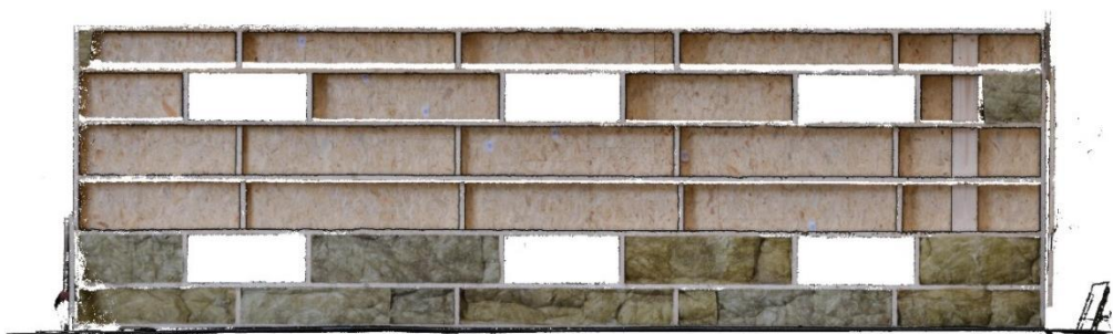
Afbeelding 11. Ortho-opname van de module tijdens de productie in de werkplaats
