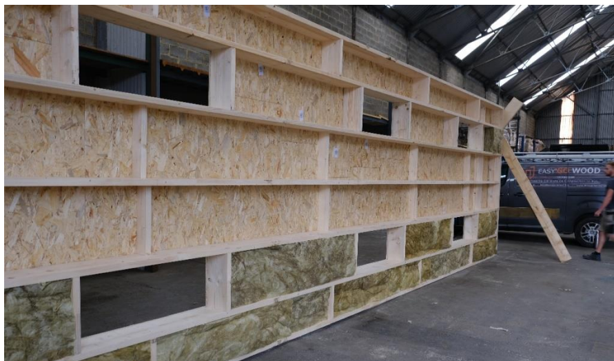
Afbeelding 10. Gedeeltelijk geïsoleerde houten constructie in de werkplaats
