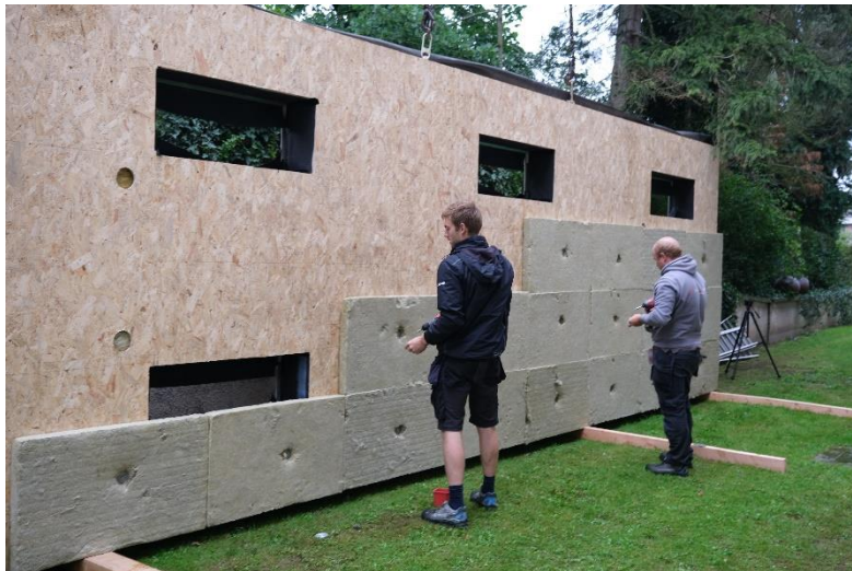
Afbeelding 18. Aanbrengen van de aanpassingslaag aan de achterzijde van de module
