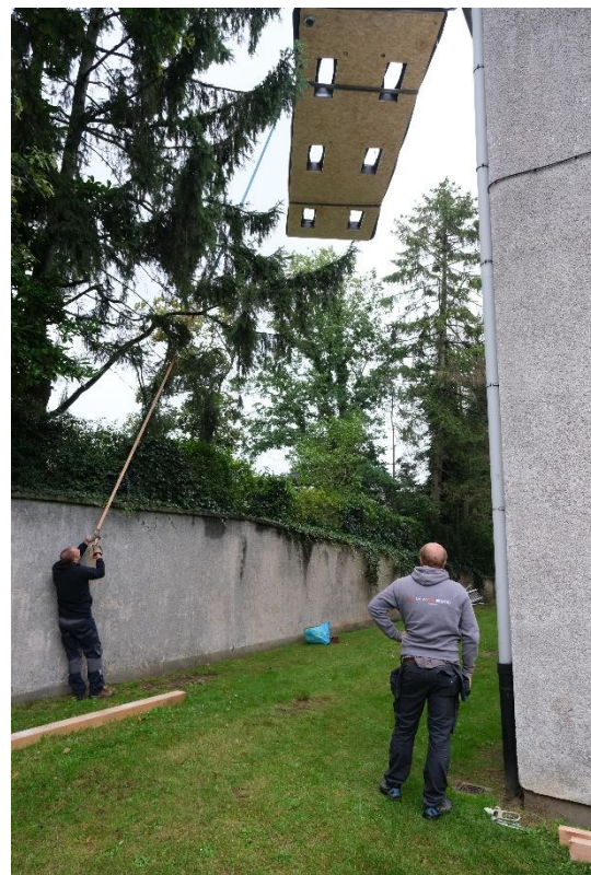
Afbeelding 17. Verplaatsing van de module naar de achtergevel
