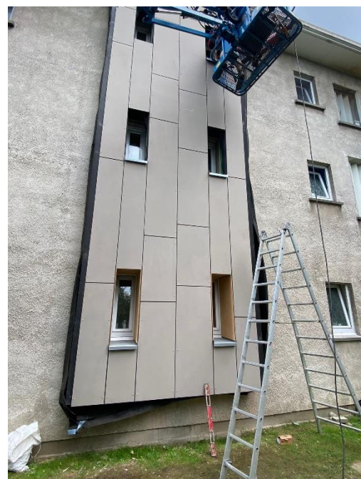
Afbeelding 20. Module verankerd aan de bestaande gevel
