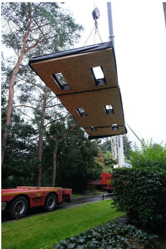
Afbeelding 16. Gebruik van een kraan om de module op te hijsen
