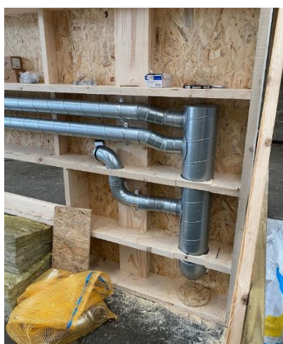
Afbeelding 12. Inbouwen van de ventilatiekanalen in de module
