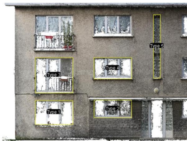
Afbeelding 10. Gebruik van de bestanden van de 3D-scan om te communiceren over de nomenclatuur van de muuropeningen
