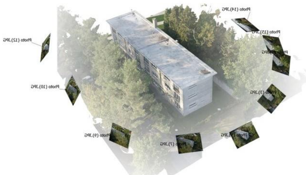
Afbeelding 4 Fotogrammetrie van het gebouw
