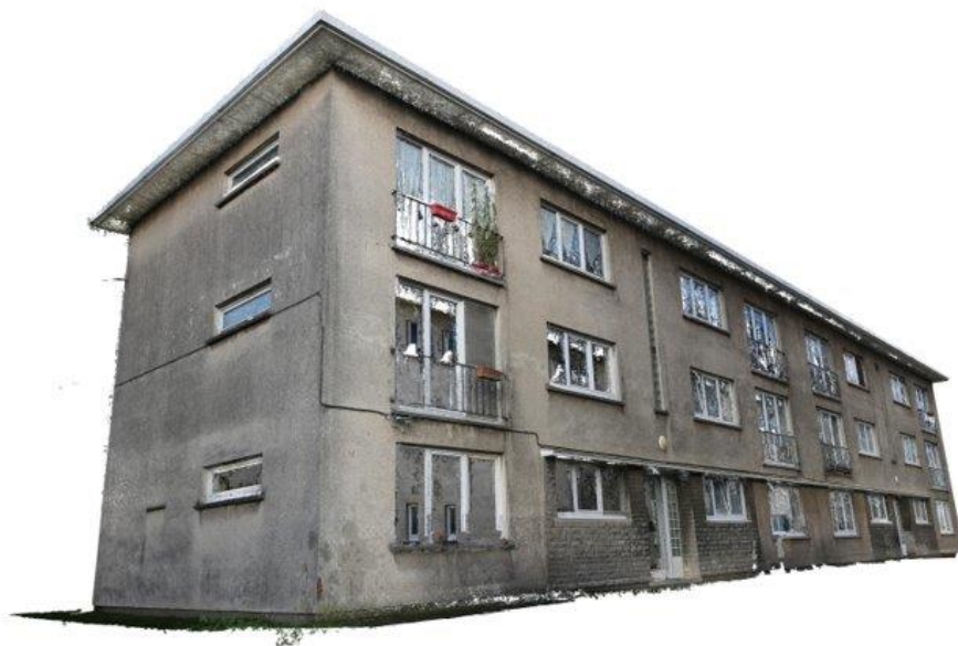
Afbeelding 3. Proefgebouw voor het Modul'air-project
