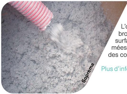
L'ouate de cellulose est obtenue par recyclage de papier journal. Celui-ci est broyé, défibré puis malaxé et traité. L'ouate est mise en œuvre par **soufflage** sur surfaces horizontales (planchers, combles), par **insufflation** dans des cavités fermées ou par **projection** humide. L'isolation en vrac permet un remplissage complet des compartiments dans les endroits difficilement accessibles.
